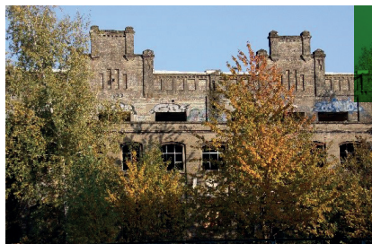
Bureau « énergie » / projet de pépinière d'entreprises © EPFL
