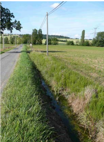
5. Fossé en eau (Verfeil - 31)
