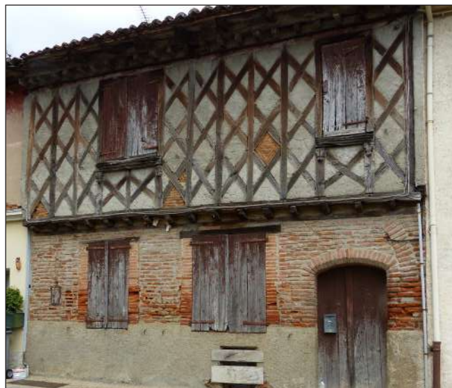
Façade en pan de bois à résille. Maison dite de la Falguière, 16e siècle
