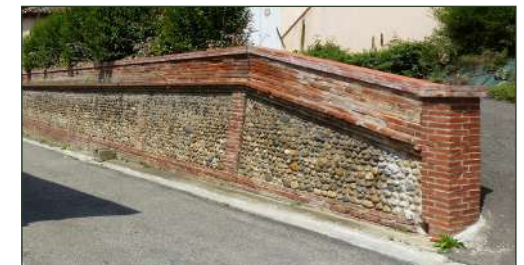
mur de soutènement : briques, assises de galets et chaperon plat
