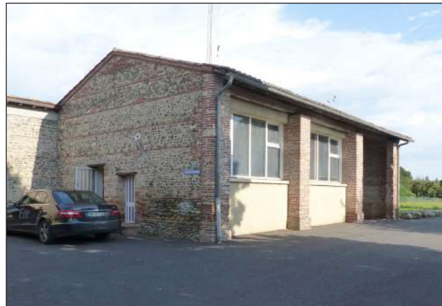
hangar sur piles de briques réhabilité - rue Joliot-Curie
