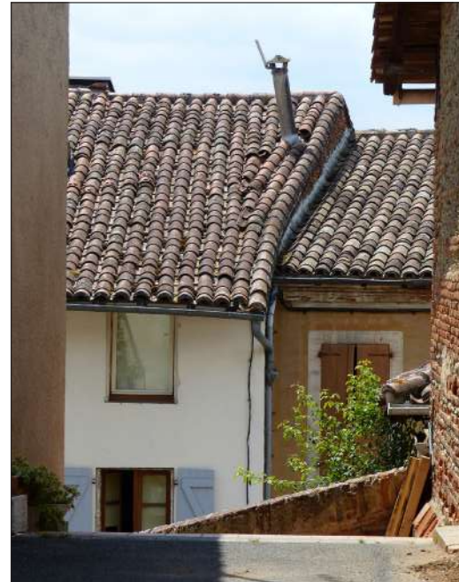
couvertures de tuiles canal
