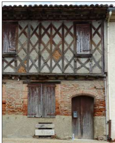
Façade en pan de bois d'intérêt majeur
