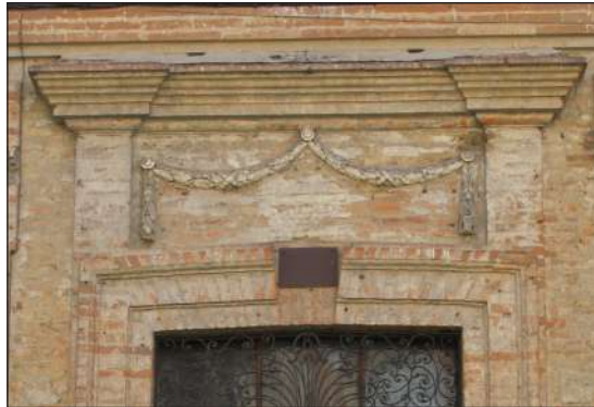
baies à entablement mouluré
