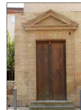
porte à entablement et fronton 19e siècle. 14, rue Bastide
