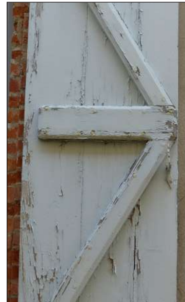
contrevents à écharpes chanfreinées - détail
