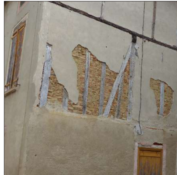
structure en pans de bois masquée par un crépi
