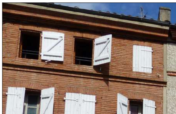
baies d'attique néoclassiques
