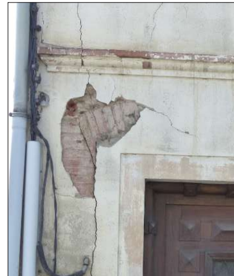
vestiges d'une baie cintrée remplacée par une baie rectangulaire
