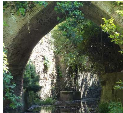
Murs de soutènement en galets sur les berges de la Segonde
