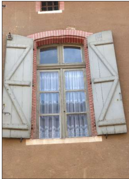
châssis à traverse dormante - contrevents à écharpes
