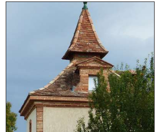
toiture en pavillon avec lanternon et épi de faîtage
