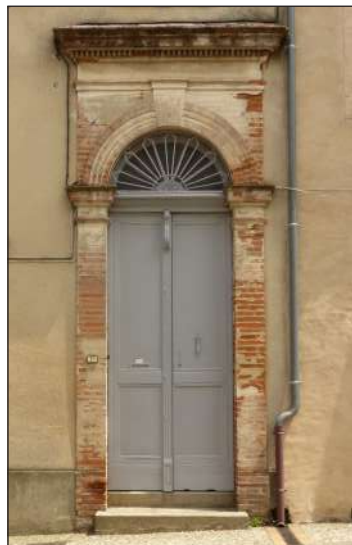
porte à vantaux moulurés et imposte rayonnante
