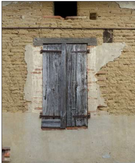
vestiges d'enduit sur parement de briques crues
