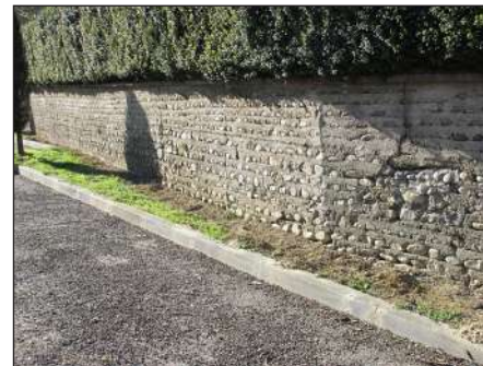
mur de clôture en assises galets
