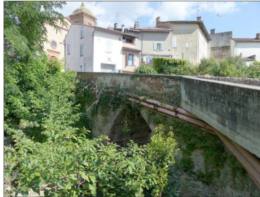
Le pont médiéval sur la Segonde, au devant de l'ancienne porte des Campanas.
