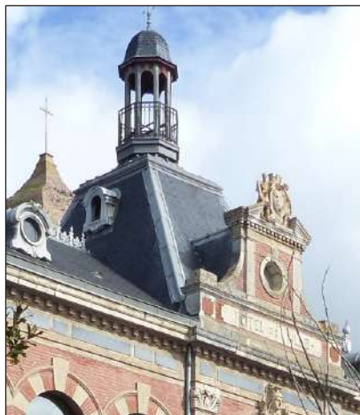
couvertures d'ardoises avec ouvrages de zinguerie - hôtel de ville
