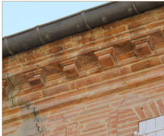
corniches à modillons
