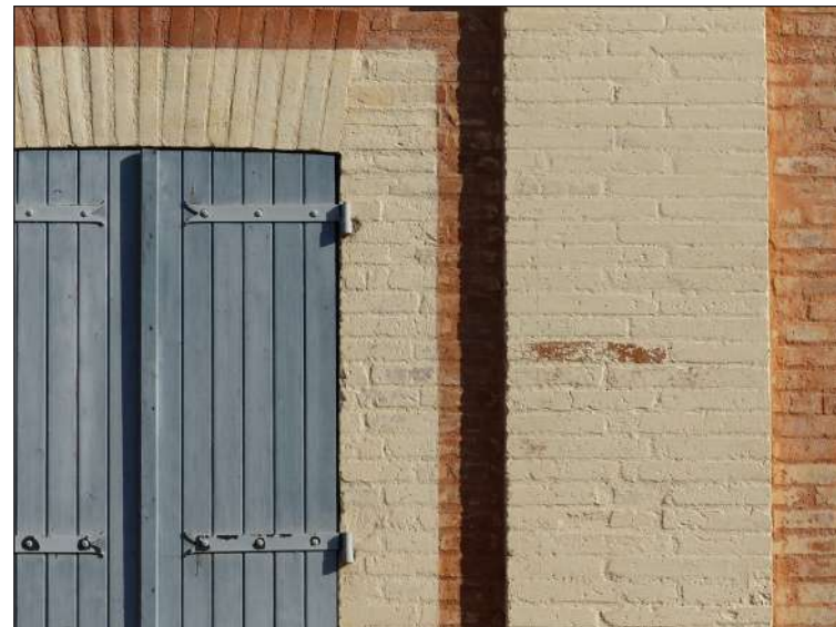
parement de briques cuites rehaussé par badigeon
