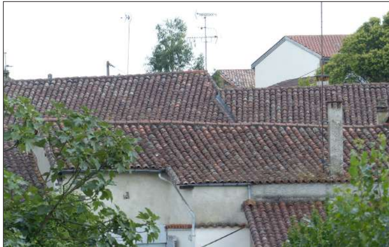
couvertures de tuiles canal
