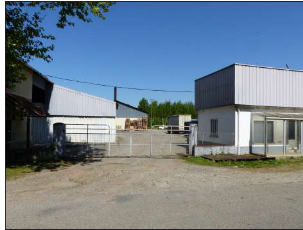
entrée de l'usine sur l'allée des Remparts
