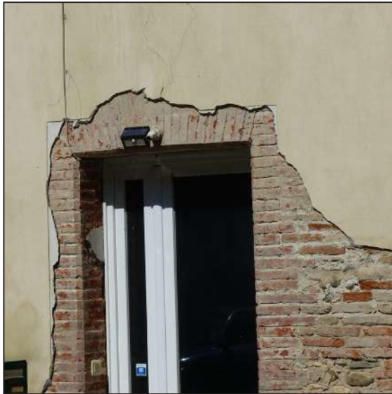
porte chanfreinée et appareil de briques
