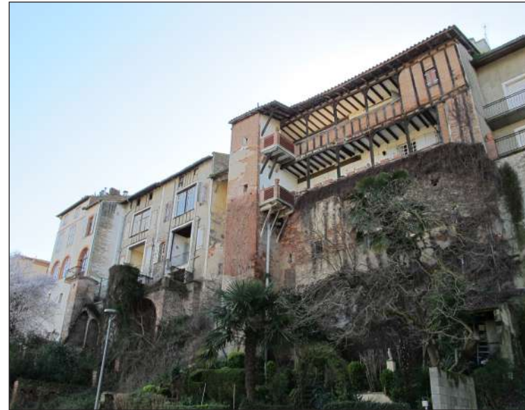
Verdun, le front urbain et ses encorbellements
