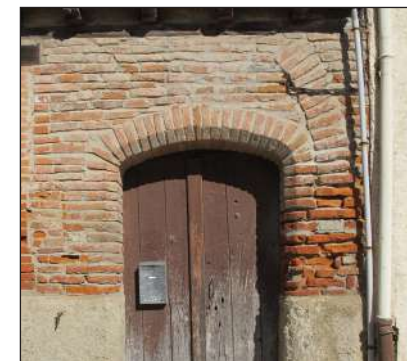
Maison dite de la Falguière, porte en anse de panier relancée au 16e siècle dans une ancienne baie médiévale en arc brisé
