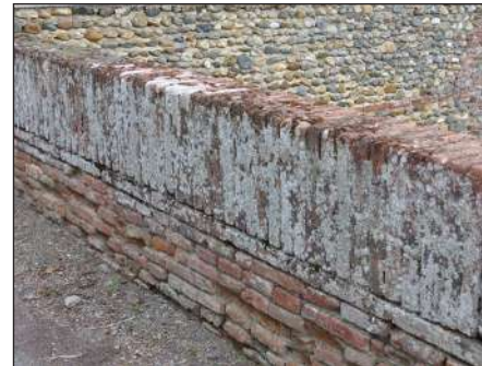
chaperon de briques sur chant (ouvrages d'art)
