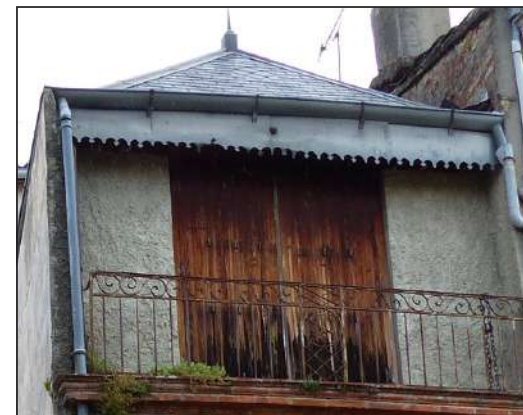
couvertures d'ardoises et lambrequin de tôle découpée
