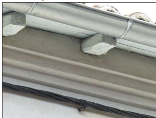
avant-toit sur corniche moulurée
