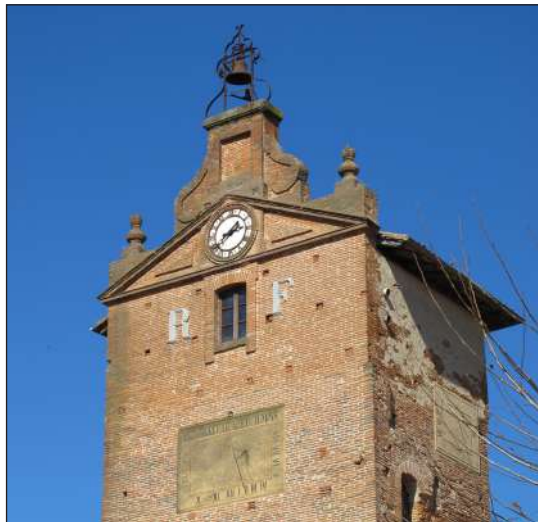
tour de l'Horloge : fronton classique (17e siècle ?), campanile de fer forgé et cadran solaire
