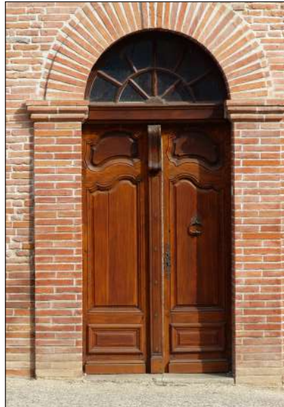
porte à vantaux moulurés et imposte rayonnante
