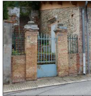
portails entre piliers à vantaux ajourés
