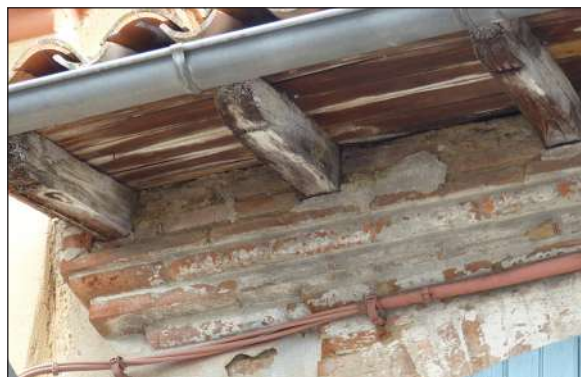
avant-toit sur corniche moulurée
