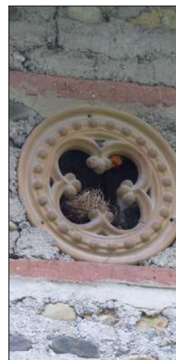
aération de comble néogothique
