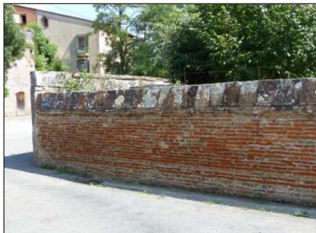
mur de clôture en briques pleines apparentes
