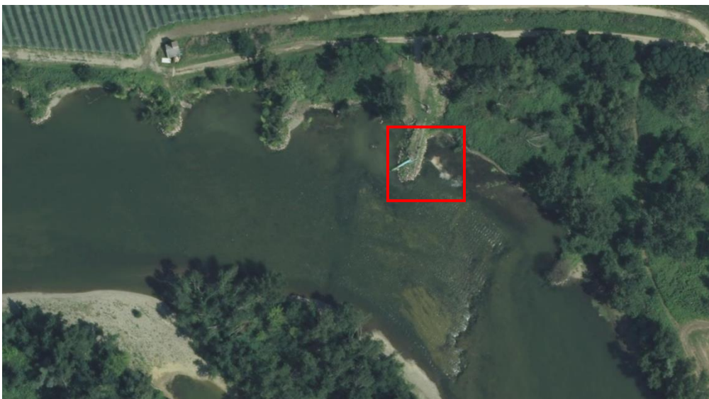
Vue aérienne du point de captage en Garonne
