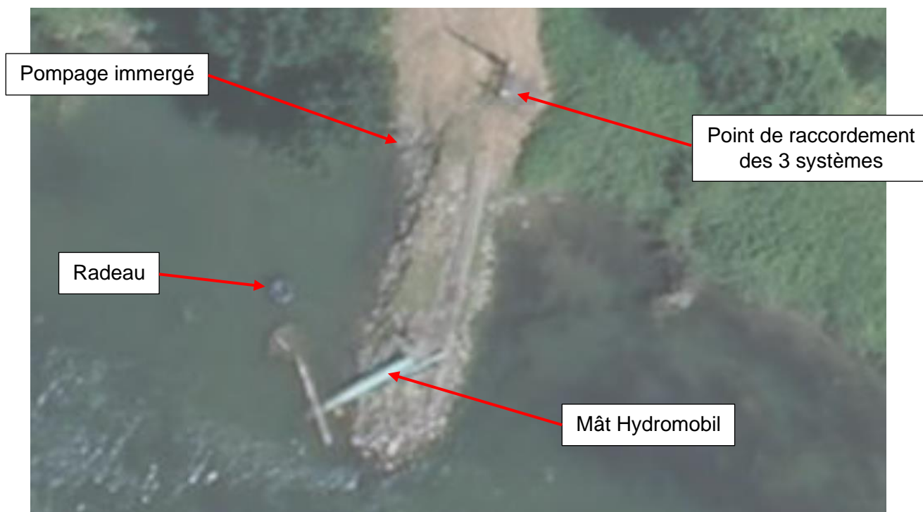
Localisation des différents systèmes de pompage
