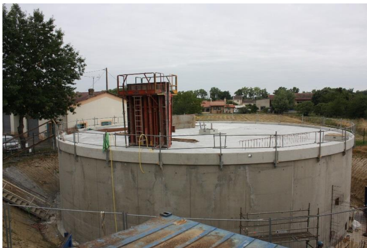
Vue du réservoir de Montech en cours de construction
