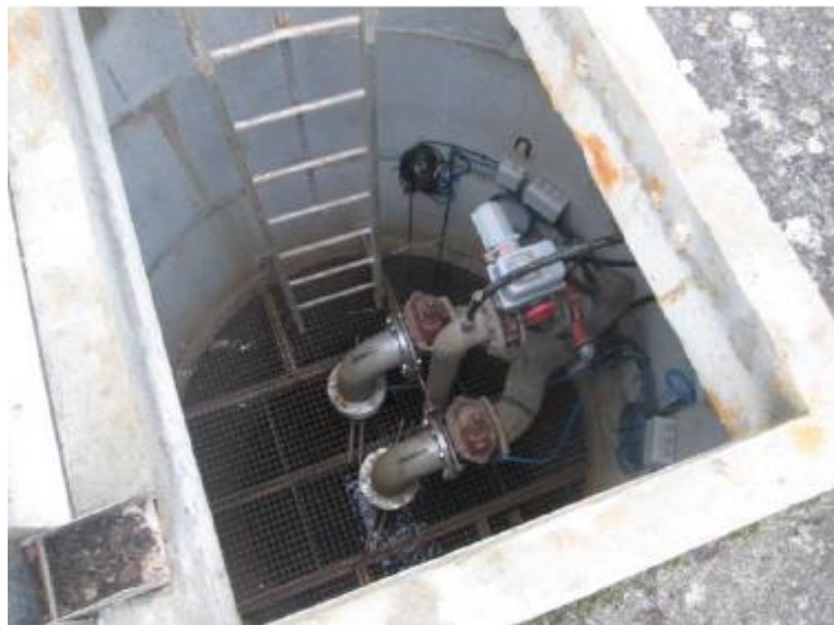
Figure 6 : Localisation et détail du puits de reprise
