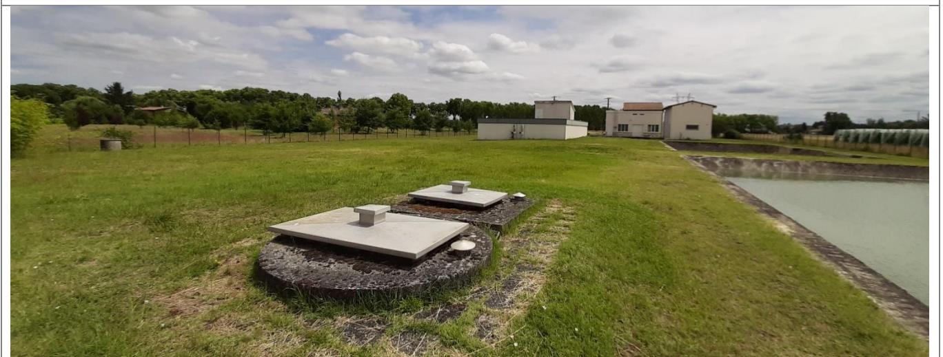
Vue générale depuis l'arrière de l'usine
