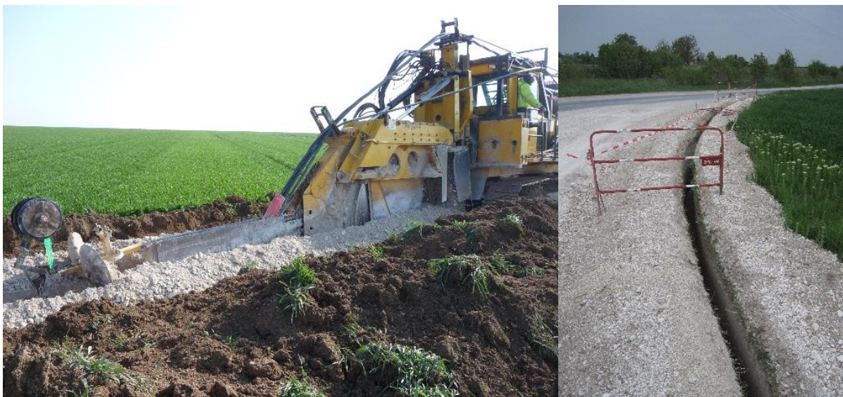
Exemple de tranchée réalisée (Source : Total Quadran)
